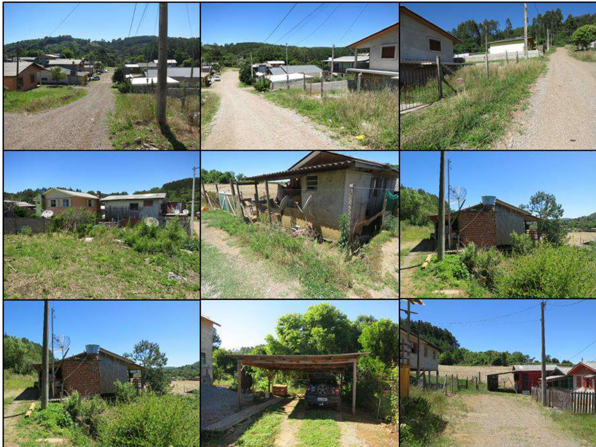
Figura 2 - Imagens da vistoria realizada na ocupação irregular objeto deste estudo
