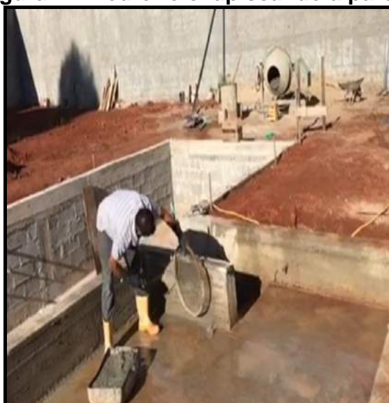
Figura 1 – Pedreiro chapiscando a parede
