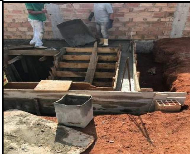
Figura 5 – Servente colocando concreto na laje.
