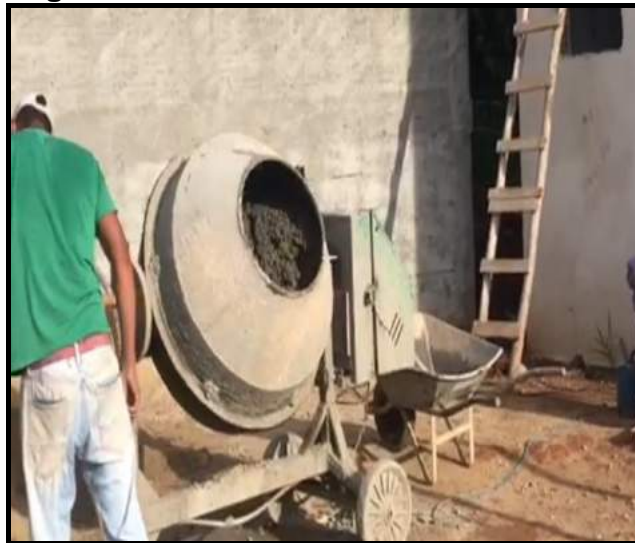
Figura 4 – Betoneira mexendo o maceiro
