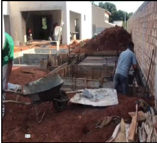
Figura 3 – Pedreiro colocando concreto na laje
