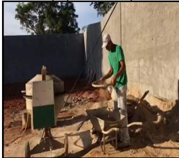
Figura 2 – Servente preparando areia para fazer o maceiro
